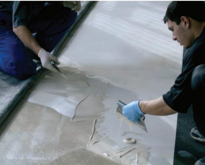
**Paste EP11** è una colla epossipoliuretana bicomponente per il fissaggio di superfici in pvc e/o gomma, per l'incollaggio totale di erba sintetica su sottofondi in CLS e per l'accoppiamento di lamina impermeabilizzante e teli in gomma prefabbricati, nella realizzazione di pavimentazioni flottanti indoor.
