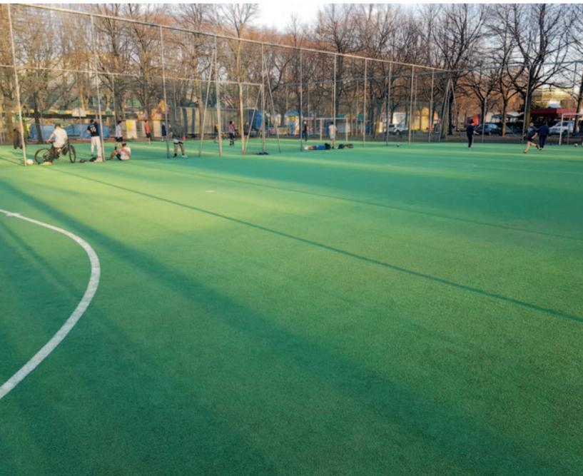
Ideale come pavimentazione sportiva polivalente. Il sistema **Premium** è realizzato in resine poliuretaniche con finitura in granulo di EPDM seminato, applicabile sia su sottofondi in CLS sia in asfalto.
