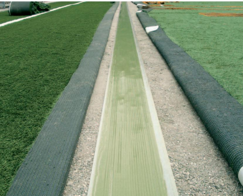
**Paste M** è un collante poliuretano bicomponente per ancorare i teli ai supporti di giunzione in poliestere nella realizzazione di campi in erba sintetica.
