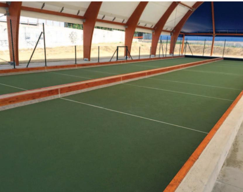
Studiato per la realizzazione di campi da bocce indoor e outdoor, **Ribosint** è un sistema a base di resine poliuretaniche con finitura in granulo di EPDM, applicabile sia su sottofondo in asfalto, sia in CLS.
