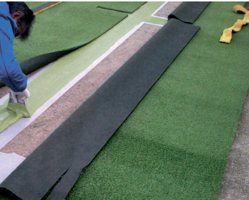
Collante poliuretano bicomponente tixotropico privo di solventi per l'incollaggio di erba sintetica su bande di giunzione: la speciale formulazione consente di lavorare in condizioni umide o addirittura bagnate. La colla non espande e aderisce bene anche se i materiali non sono completamente asciutti. L'impiego del **Paste MP 150**, possibile anche in condizioni di elevata umidità permette di prolungare i tempi di lavoro giornalieri e stagionali.
