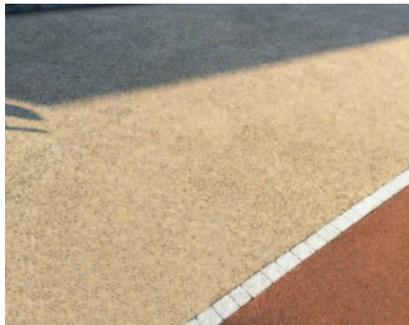
**Drystone Floor** è una pavimentazione in pietra, drenante, realizzata in opera con l'impiego di inerti dall'elevato valore estetico e una speciale resina legante trasparente.
