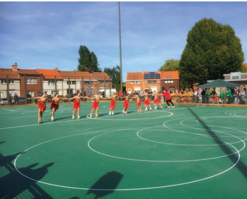
Il sistema **Rollertop** nasce per la realizzazione di pavimentazioni per piste di pattinaggio artistico e in linea e per velodromi, specificatamente su sottofondo in tappetino bituminoso. La particolarità del rivestimento utilizzato consente di ottenere una superficie rigida, omogenea, antisdrucciolo, con caratteristiche tecniche particolarmente idonee al pattinaggio.
