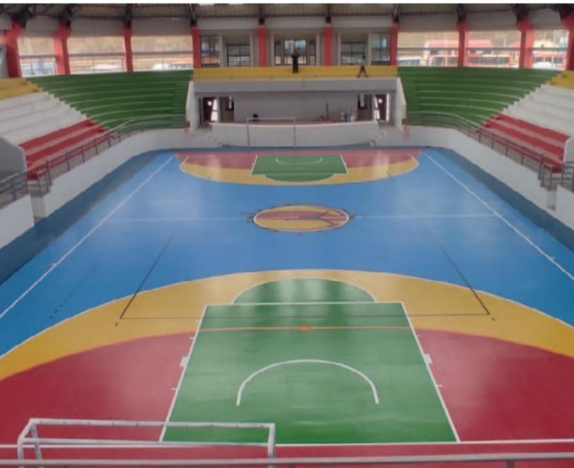
Il sistema **Pavisint SL 75 RW** combina l'elasticità e il comfort propri di una superficie polivalente, caratterizzata dal sottofondo in gomma, alla resistenza meccanica e alla scorrevolezza della finitura poliuretanic. La particolarità del rivestimento di finitura è data dall'impiego di due diversi strati di resina poliuretanic che insieme conferiscono alla pavimentazione le necessarie proprietà richieste dagli sport esercitati con sedie a rotelle e pattini.
